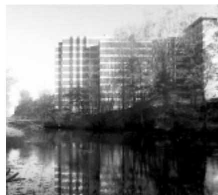
Gävle sjukhus vid Gavleån
